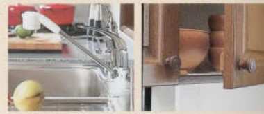
下げ止水レバー水栓 耐震用プルラッチ
