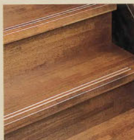
210mmの踏面と滑り止め加工
