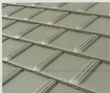
モノコグリーン施工
