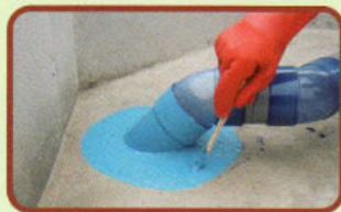
配管周囲に コンコートEV を塗布します。
