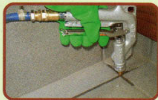
②防蟻薬剤を注入します。
