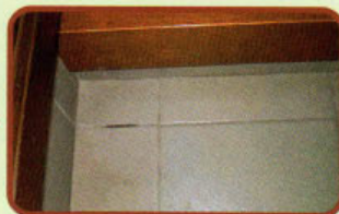
③目地モルタル充填します。 (ヨーロッパアンタイル仕上がり)
