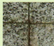
御影石の施工後
